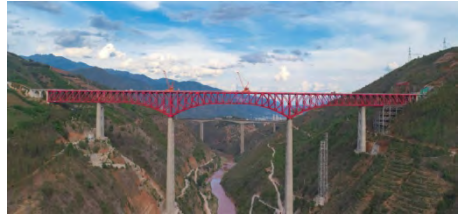
中老铁路全线通车运营，这是“一带一路”倡议提出后，首条以中方为主投资建设、全线采用中国技术标准、使用中国设备并与中国铁路网直接连通的国际铁路。中铁工业参建元江双线特大桥等多项重点工程项目。
