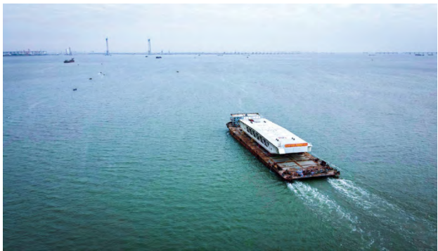
深中通道中山大桥首段钢箱梁顺利启运。
