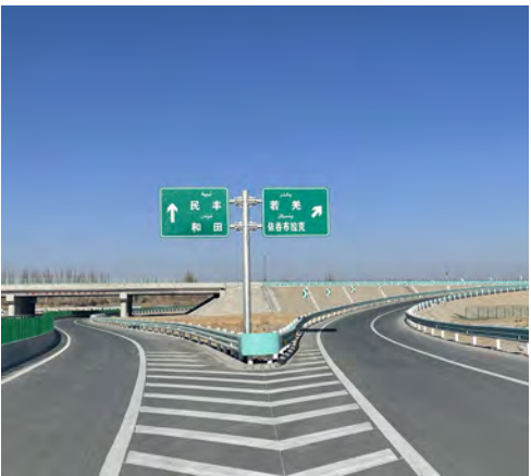
国内一次性建成里程最长的高速公路——新疆若羌高速公路建成通车，公司承接该项目213.3千米防撞护栏、焊接网隔离栅，标识标牌、防眩板等的制造任务，工程量共计约2.6万吨。
