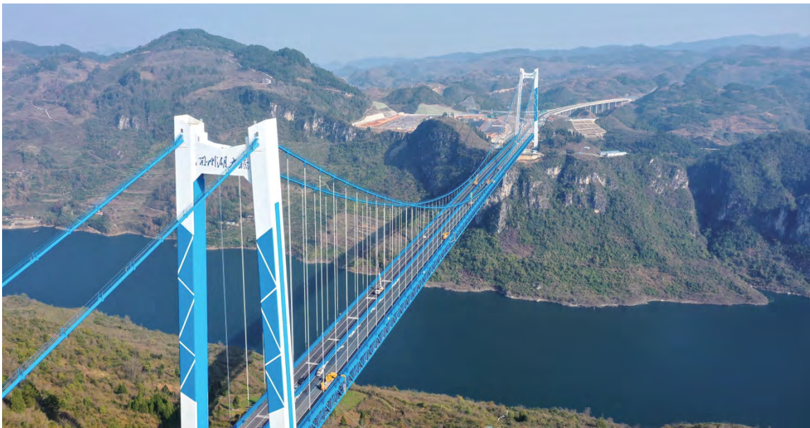
公司参建的亚洲第四大山区跨峡谷类型悬索桥——开州湖特大桥。
