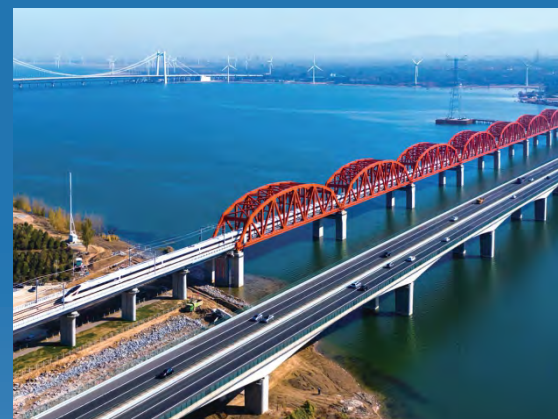
京张高铁官厅水库特大桥
