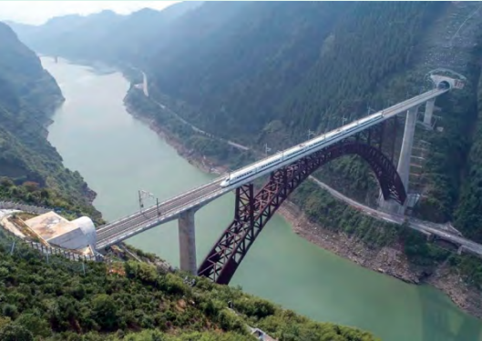
2021 年 12 月 6 日，“湘西最美高铁”张吉怀铁路正式开通运营。图为公司参建的张吉怀铁路西水大桥。
