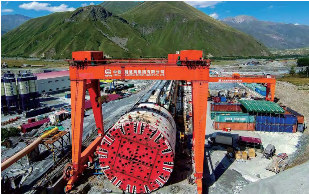
全球最大直径全断面硬岩掘进机（TBM）“极限号”顺利掘进，开启了“一带一路”重点交通建设项目——格鲁吉亚南北走廊 KK 公路隧道建设的新篇章。
