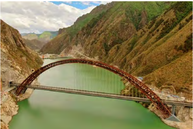
拉林铁路正式开通运营。图为藏木雅鲁藏布江双线特大桥。
