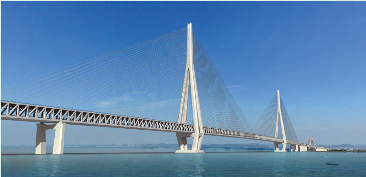
公司中标常泰长江大桥、龙潭过江通道跨江大桥、南京仙新路过江通道、巢马铁路马鞍山公铁两用长江大桥等十余座万吨级以上项目。图为常泰长江大桥。
